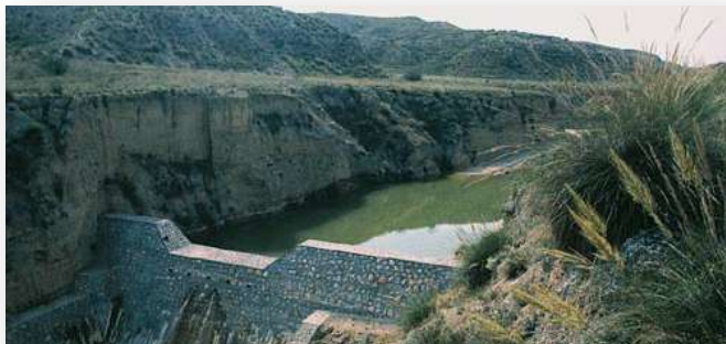
Construcción de obras y actividades para el control de caudales
