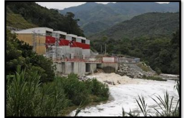
HIDROELECTRICA CARLOS LLERAS
