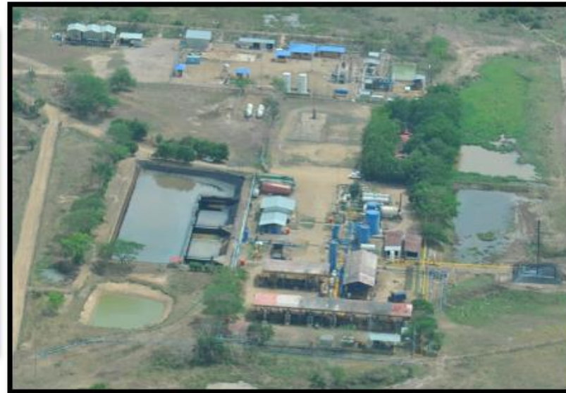
ESTACIÓN LA GLORIA (Aguazul-Casanare) PLANTA DE APROVECHAMIENTO GN EN CAMPO PETROLERO PARA AUTOGENERACIÓN
